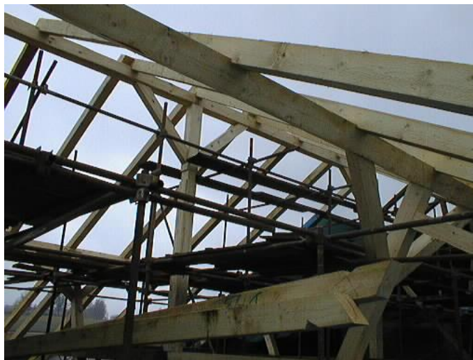
Záběr z rekonstrukce krovu hlavní budovy
